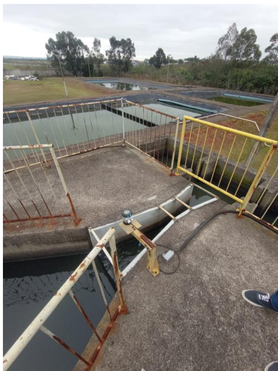
Imagem 05: Estrutura da calha parshall
