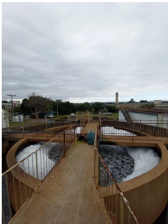
Imagem 07: Estrutura do tanque aerado
