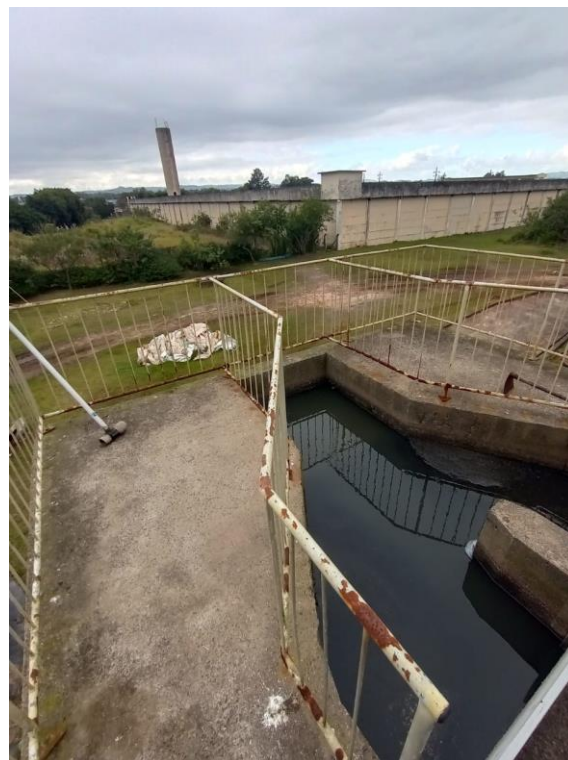
Imagem 04: Estrutura da calha parshall
