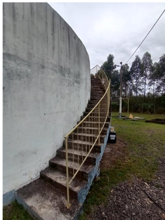
Imagem 06: Escada do tanque aerado
