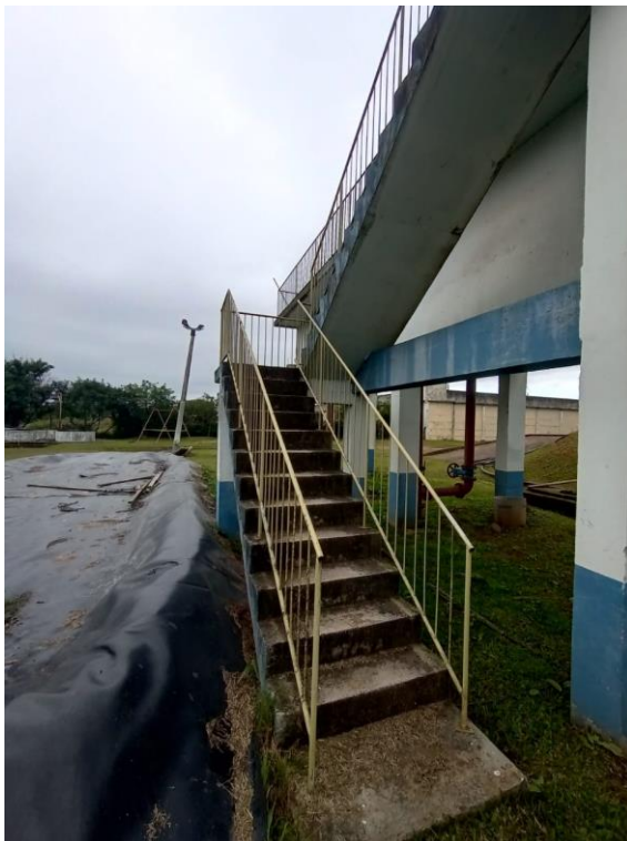
Imagem 01: Escada da estrutura da calha parshall
