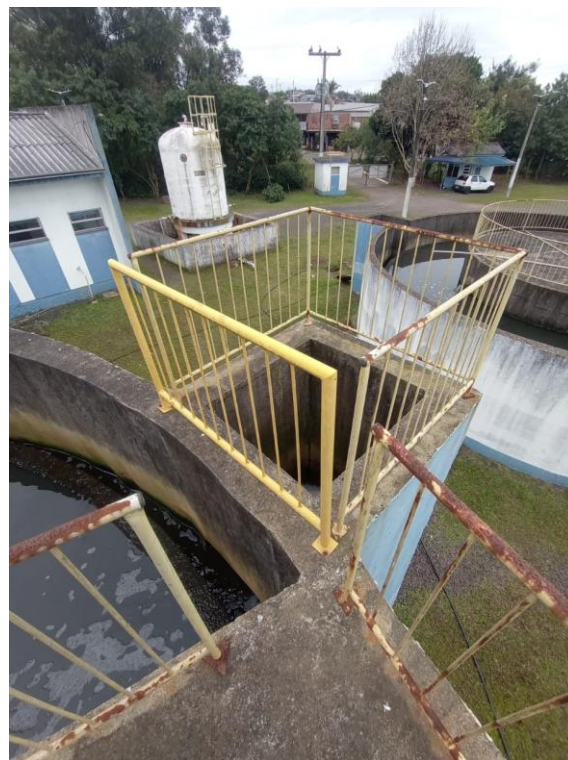
Imagem 08: Estrutura do tanque aerado
