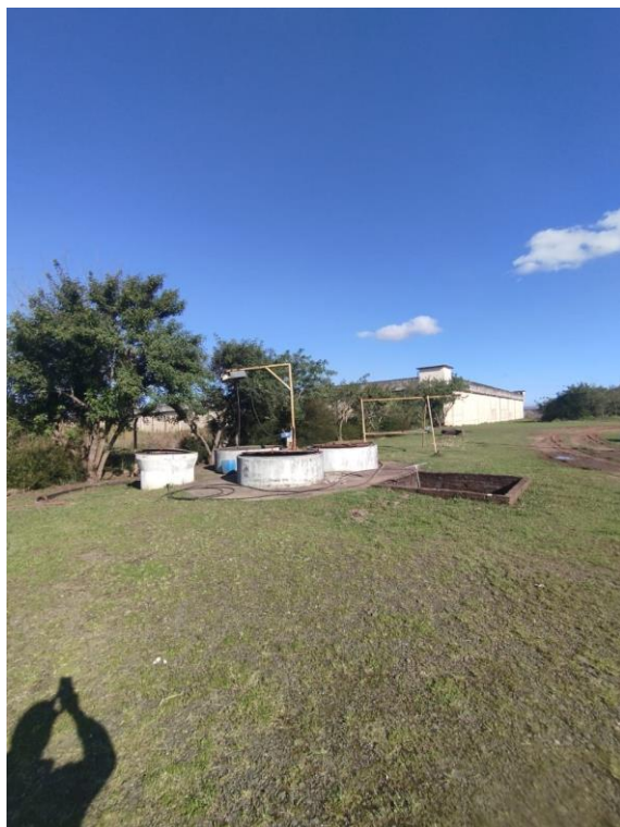
Imagem 15: Poços e caixa de manobra 1
