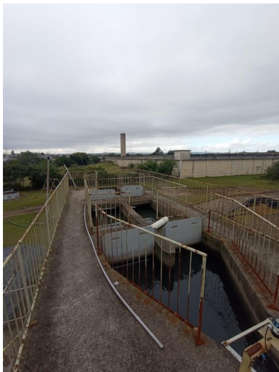
Imagem 03: Estrutura da calha parshall
