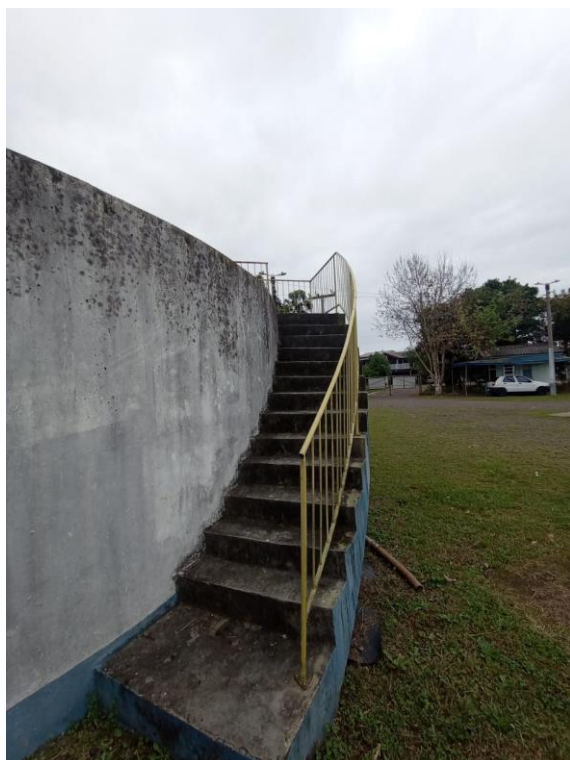
Imagem 09: Escada do tanque anóxico
