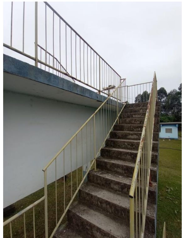
Imagem 02: Escada da estrutura da calha parshall
