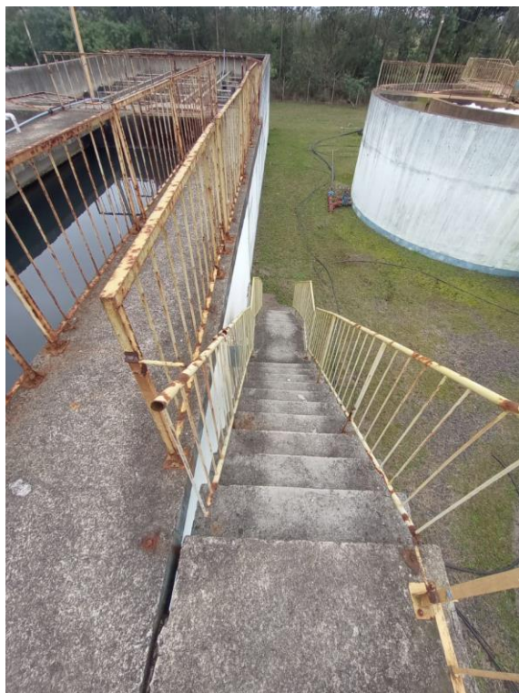
Imagem 11: Escada do UASB
